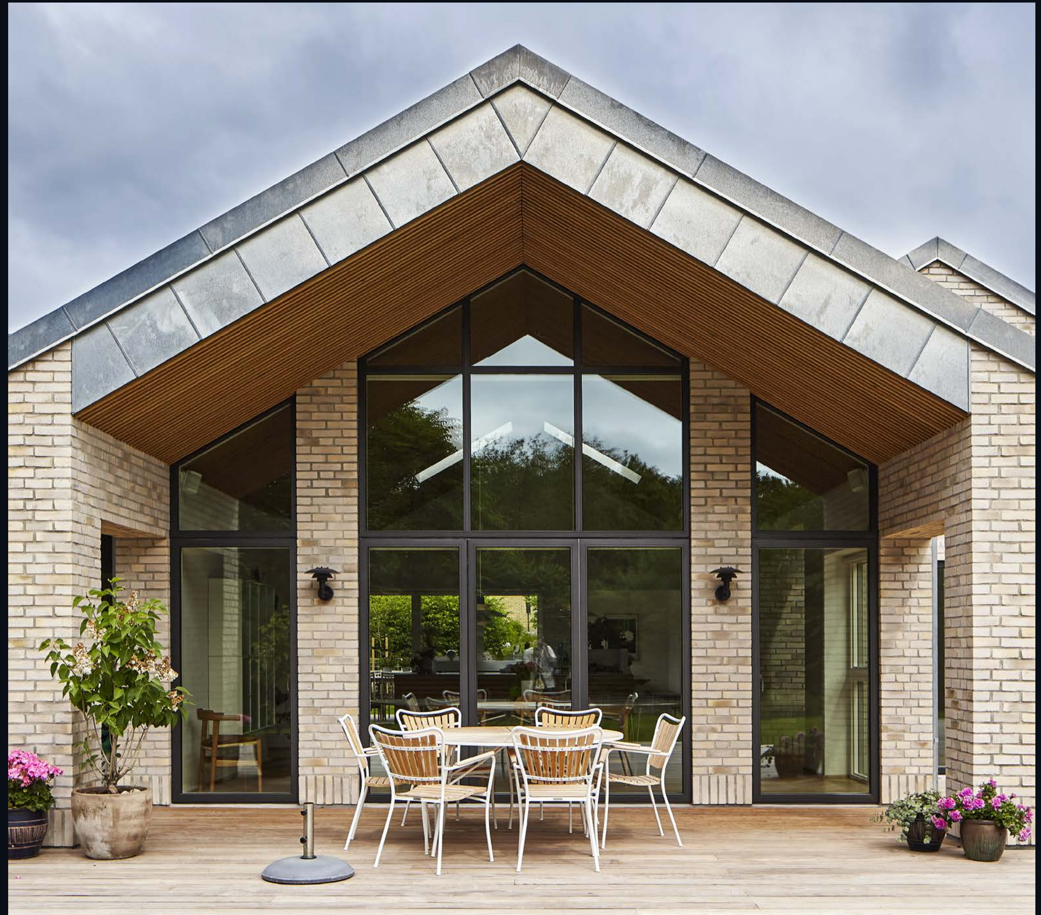
Træ/Alu Daylight elementer bygget til kip
