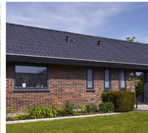
70'ER PARCELHUS med topstyrede vinduer
