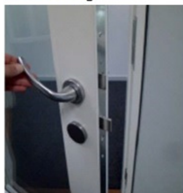
6. Montering: Kontroller at elementets funktion via grebet fungerer i både åben og lukket position.
