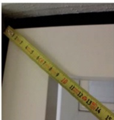
4. Montering: Krydsmål kontrolleres på karmen.
