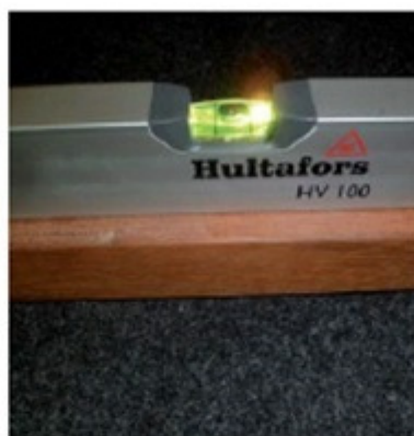
2. Montering: Produkter kontrolleres om bundkarmen er monteret i vatter.
