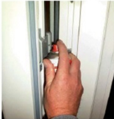
10. Smøring: Produkter rengøres og smøres i hængsler.
