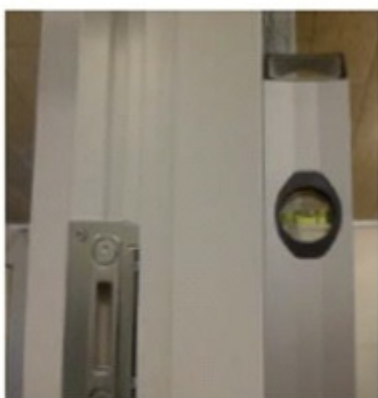
1. Montering: Produkter kontrolleres om karmen er monteret i lod.
