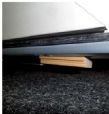
5. Montering: Ved døre, kontroller at transportklods under rammen er fjernet.
